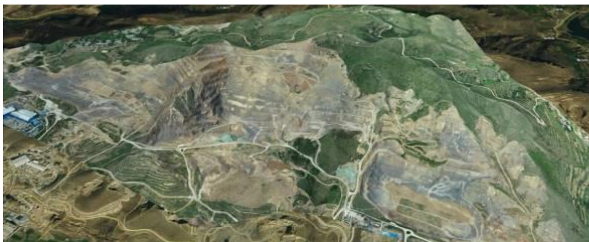
照片 1-6 老采坑航拍照片
