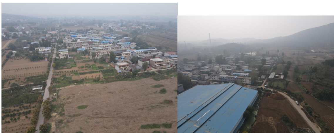
照片 3-2 已建成道路水土保持设施现状
