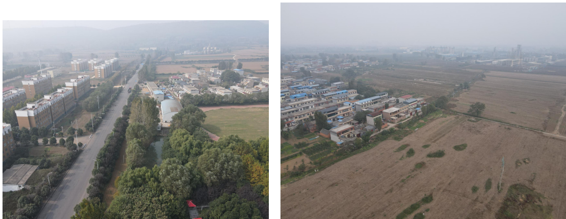
照片 3-3 在建道路水土保持设施现状
