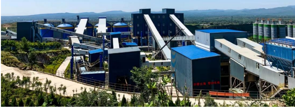
照片 3-1 生产线厂区照片
