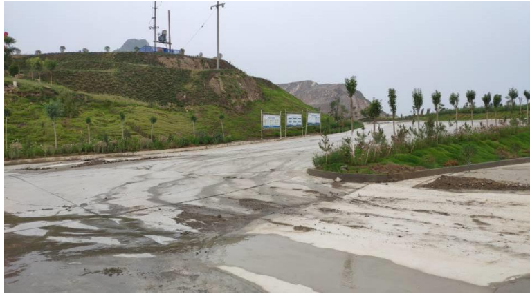
照片 3-2 矿山道路照片
